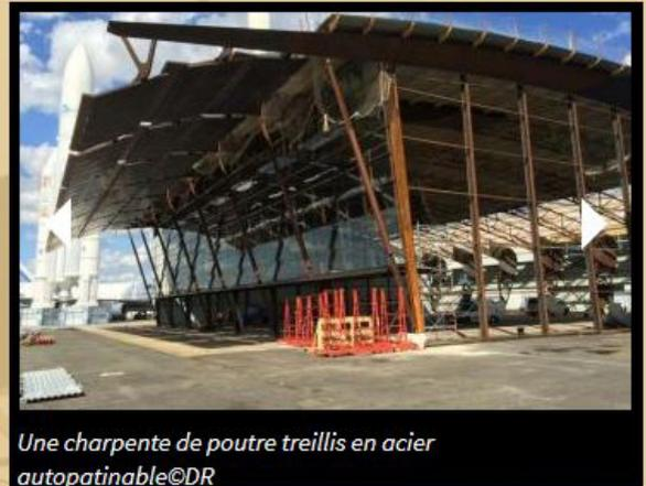
Une charpente de poutre treillis en acier autopatinable©DR
