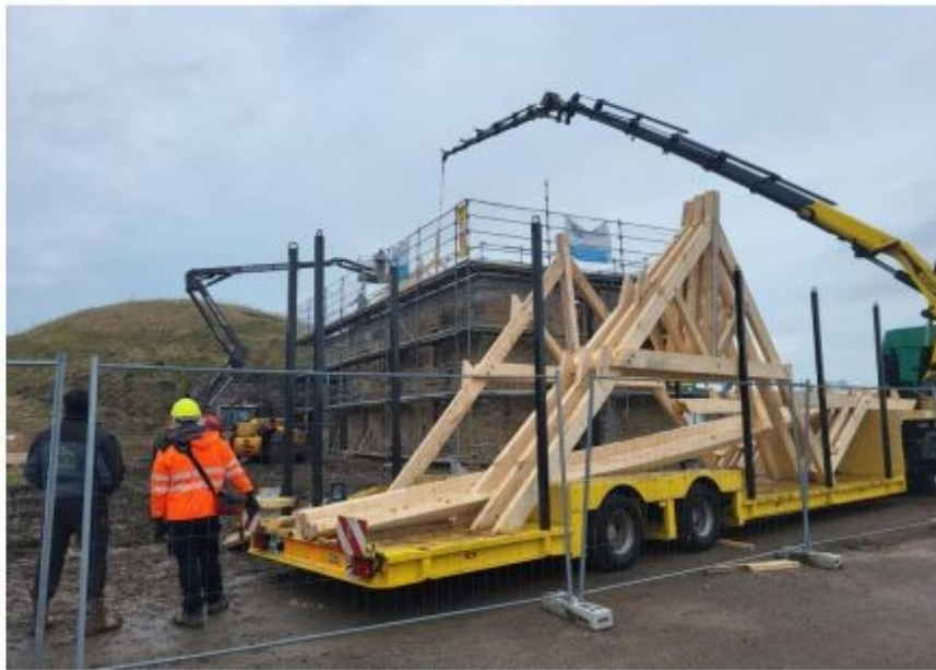
Les employés de CSB posent les premières sections de charpente du logis du major au Fort Risban, le 23 janvier.
