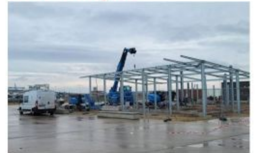
TERRASSE L'armature métallique de la future terrasse du restaurant de la cité définitive du Dragon a été posée la semaine dernière. Deux sections successives, de hauteur décroissante, doivent à la fois prolonger la perspective depuis l'abri du Dragon.
